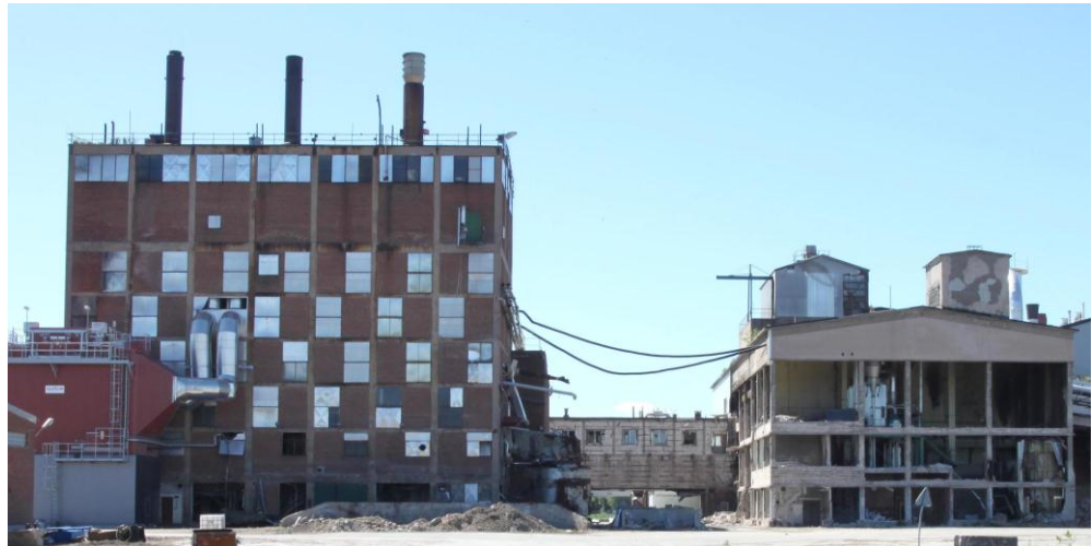
17. Pannhuset med dess karaktäristiska fasadgestaltning.
