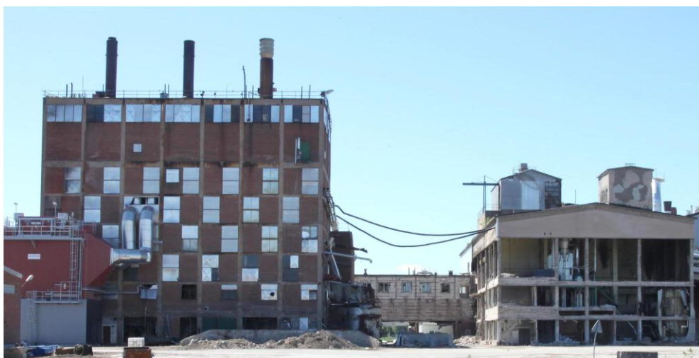
Pannhuset med dess karaktäristiska fasadgestaltning.
